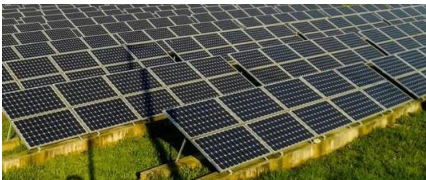
Εικόνα 5 : Εγκατάσταση φωτοβολταϊκών πάνελ για παραγωγή ηλεκτρικής ενέργειας
